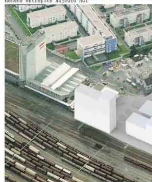
Après la réalisation du Plan de Quartier Renens Entrepôts KCAP Architects & Planners Silo Renens - Compléments - 10 juillet 2013
