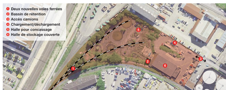
Aménagée pour stocker et traiter les matériaux du chantier de la gare de Lausanne, la plateforme de Longemalle vise des objectifs d'optimisation des transports et de récupération des matériaux.
