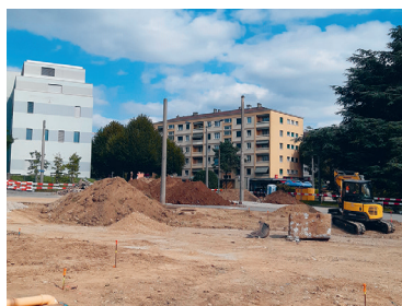
Préparation du chantier du carrefour Verdeaux-Temple
