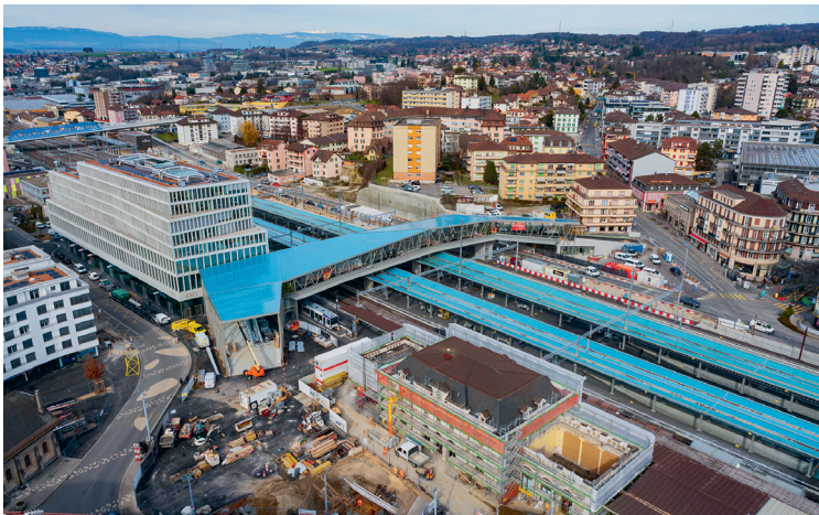
Fin février, la passerelle Rayon Vert est en cours de finition © www.photodrone.pro
