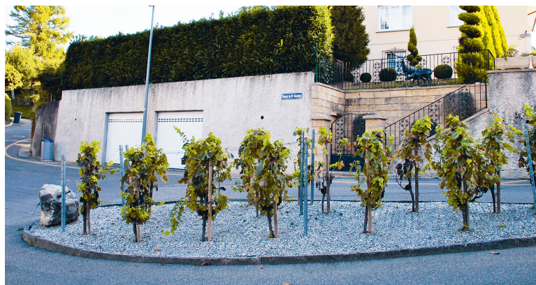
Situé dans le quartier du Village, le chemin de St-Georges relie le chemin de la Creuse au chemin de Broye.
