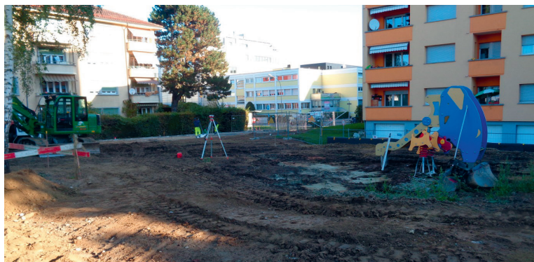
Etat des travaux de réaménagement le 21 septembre 2017.
