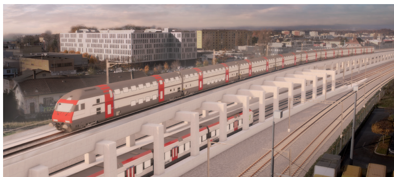
Image de synthèse du saut-de-mouton qui enjambera les voies et permettra aux trains de se croiser entre Renens et Prilly-Malley © CFF.
