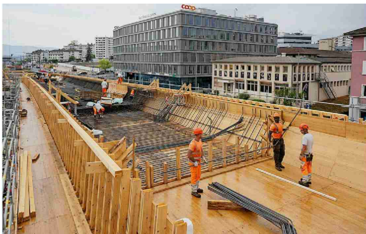
La structure en bois préfigure le pont, mais elle n'est qu'éphémère. Elle servira de moule pour couler le béton.
