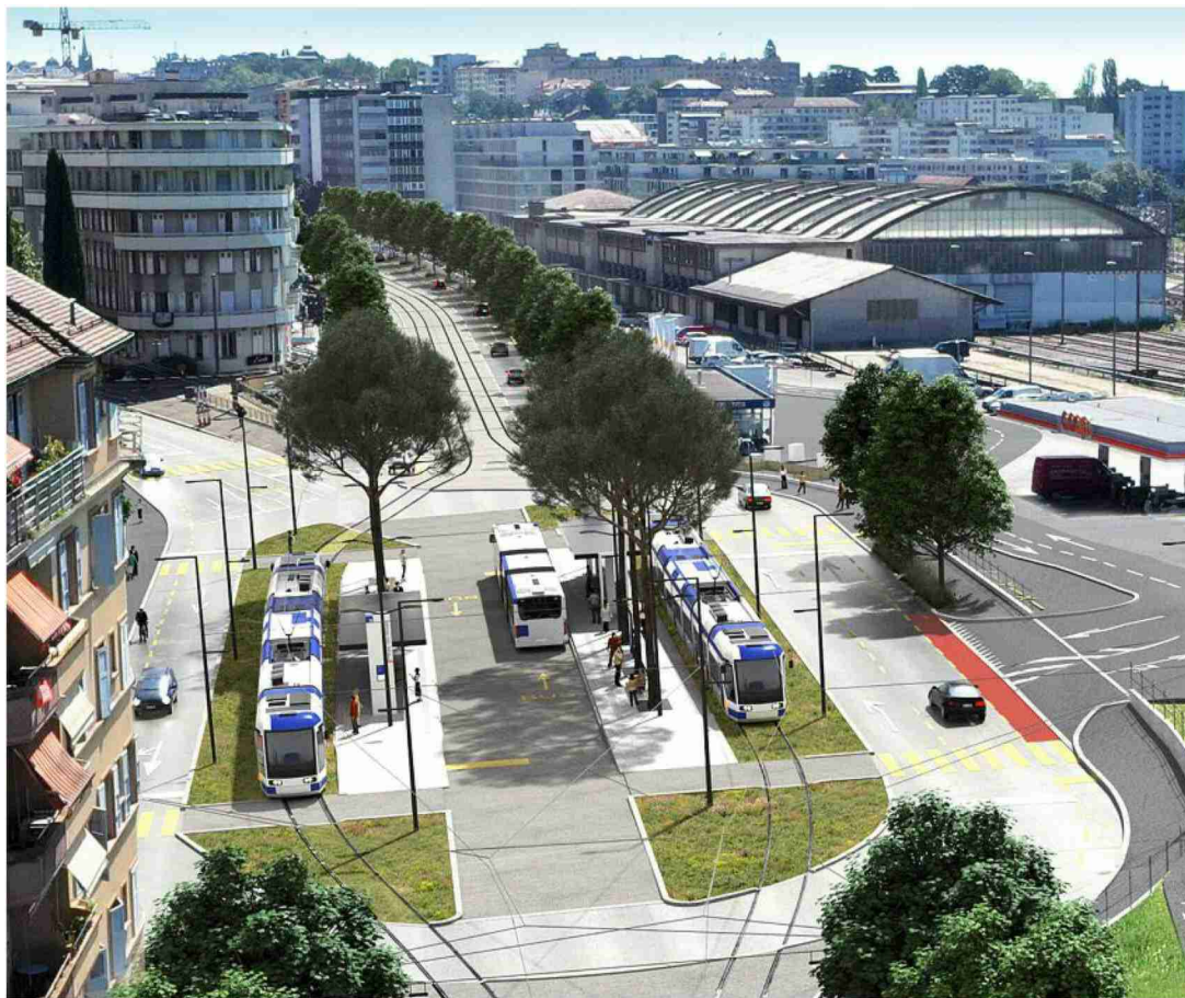
Vue aérienne du secteur de Prélaz-les-Roses avec le futur tram. TL
