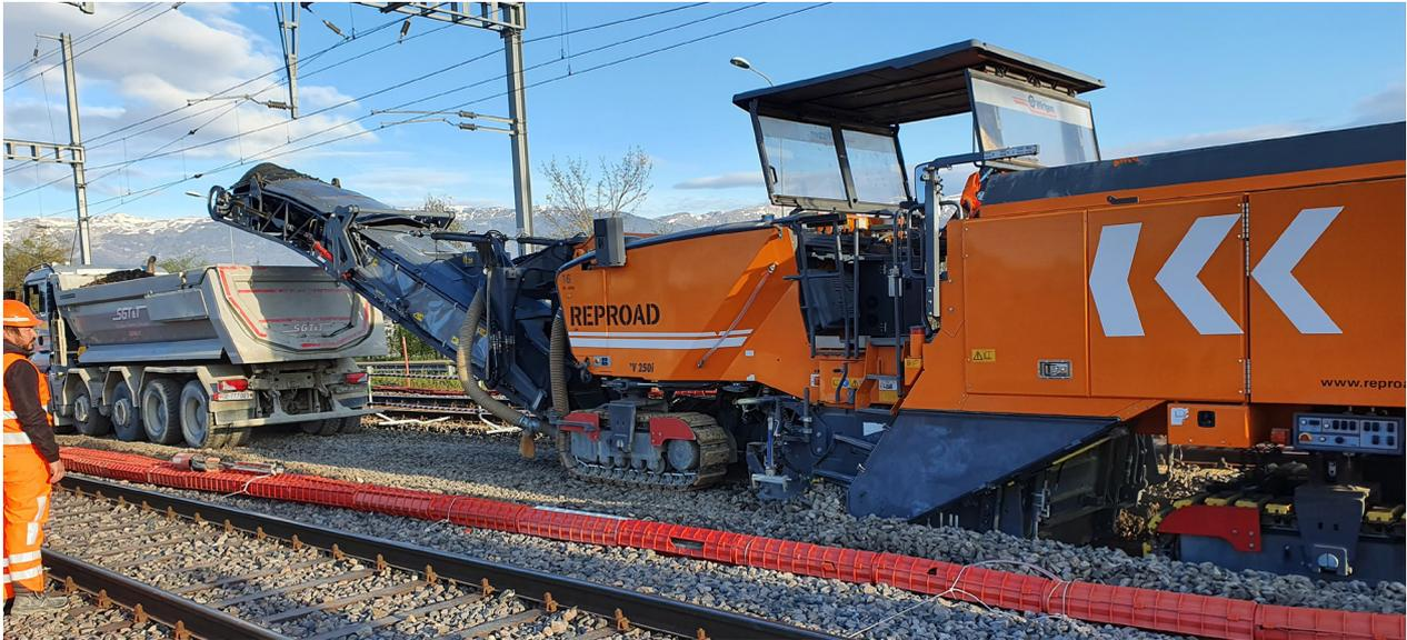
La raboteuse est une machine spécifique qui permet d'enlever le ballast plus rapidement que d'ordinaire.
