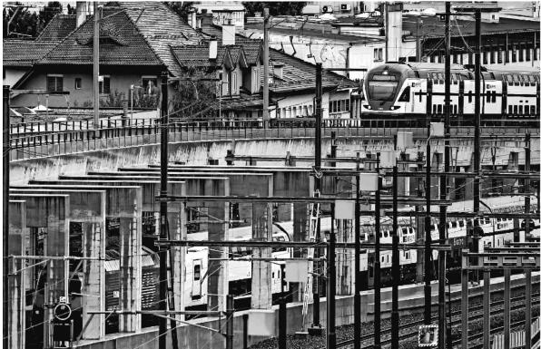
Unique sous en Suisse. le sautde-mouton de l'Ouest lausannois permet à deux trains de circuler l'un au-dessus de l'autre. KEYSTONE
