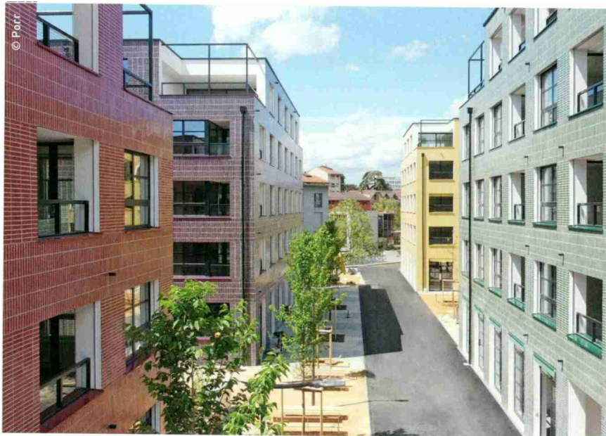
Porr a remis aux CFF une zone en construction de quatre immeubles au Parc du Simplon
