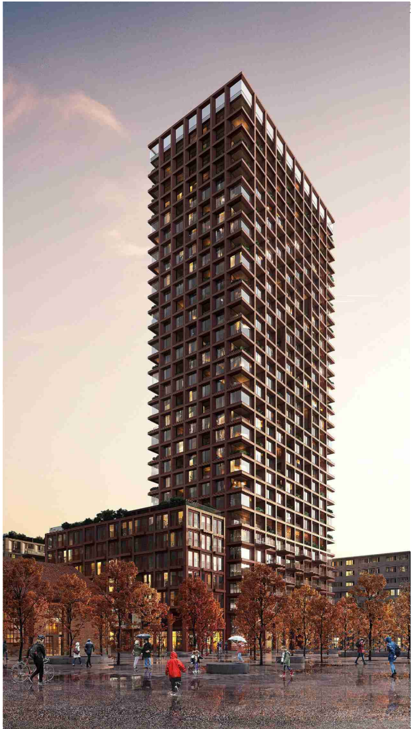
Voici à quoi devrait ressembler la plus haute tour d'habitation en bois du monde. Prévu à Winterthour, le projet est au stade de l'étude préliminaire. Ina Invest / Implemia
