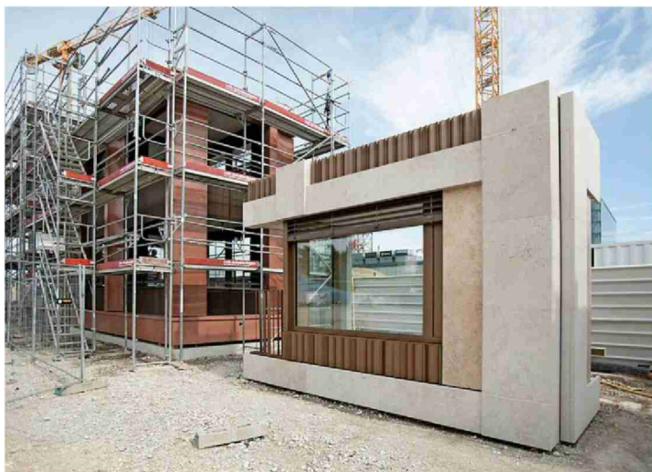
En bordure de la place de la Malleytte, deux prototypes de façade sont exposés à la vue du public. ODILE MEYLAN
