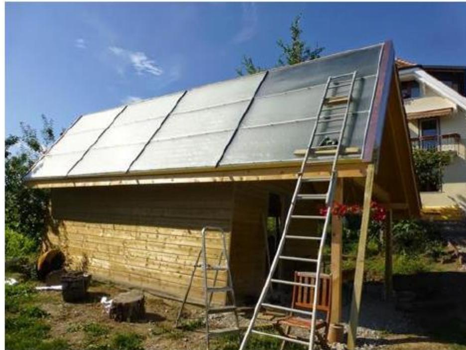
Lavanchy, Lutry. Rénovation. 150m<sup>2</sup> chauffés. Famille de 5 personnes. 18m<sup>2</sup> solaire qui font cabanon de jardin, + 6m<sup>2</sup> anciens sur le toit récupérés, poêle hydro, distribution normale + à thermosiphon, ventilation pour sèche-linge en autoconstruction. Bois ~ 2 stère/an
