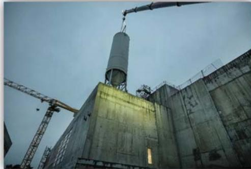
En cours depuis 2018 déjà, le montage d'équipements électromécaniques dédiés au traitement de l'eau s'est poursuivi en 2019 avec l'intégration spectaculaire, par le toit des bâtiments, de silos de stockage de chaux (produit ajouté au traitement de l'eau) et de silos de stockage de graisse en vue de leur digestion.
