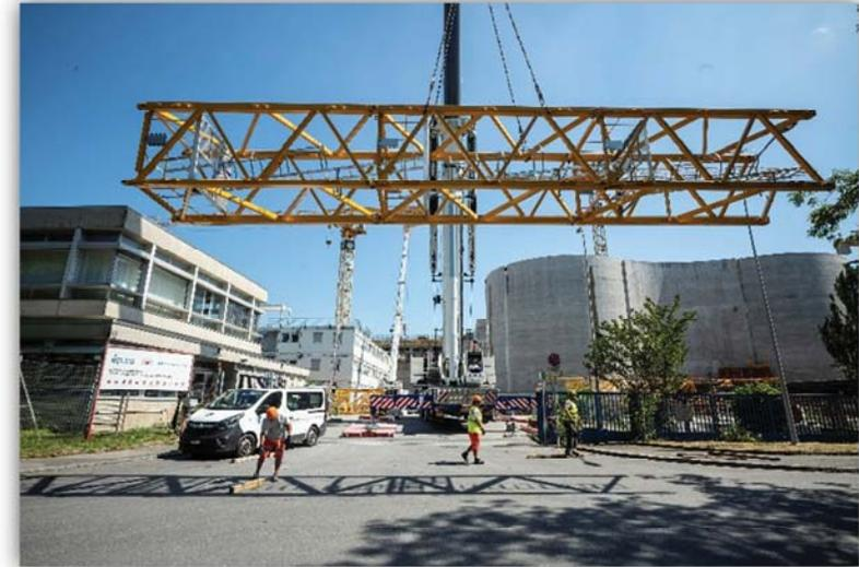
le démontage de la dernière grue-à-tour, c'est sans compter leur retour pour, d'une part investiguer un défaut d'étanchéité autour des deux digesteurs en rapport avec la nappe phréatique, et d'autre part colmater les fuites dans les bassins du bâtiment des prétraitements et de celui du traitement primaire. La chasse aux fuites et leur élimination par injection de résine dans le béton s'est déroulée durant le dernier trimestre de 2019 et se poursuivra encore en début d'année 2020.
