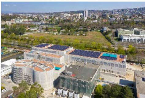
En été, les tests de mise en chauffe des digesteurs ont démarré. Remplis uniquement avec de l'eau, les digesteurs ont été montés à une température de 35°C, permettant ainsi de contrôler le parfait fonctionnement des pompes, échangeurs, etc. indispensables à cette chauffe. Puis le maintien en température des digesteurs a été stoppé. Au printemps 2021, les digesteurs seront mis définitivement en service avec des boues et commenceront alors à produire du biogaz.
