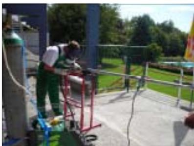
Aquasplash - Soudure des tuyaux d'alimentation des capteurs solaires
