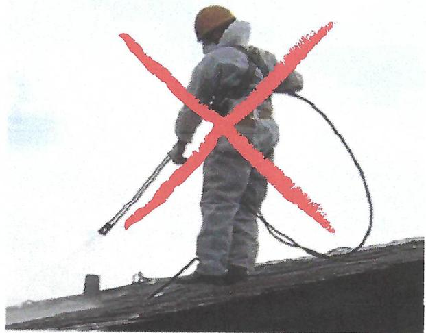
3 Ne pas utiliser de nettoyeur à haute pression
