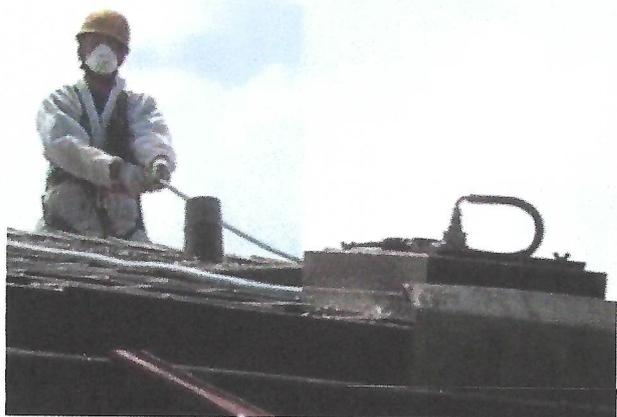
4 Système de nettoyage de surfaces amiantées avec circulation d'eau régulée
