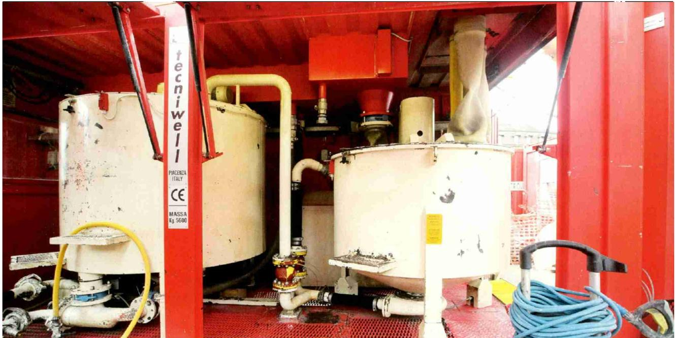
Le coulis de ciment est fabriqué et stocké sur place. Il est expédié sur chaque site de forage par des tubes qui les relient aux cuves.
