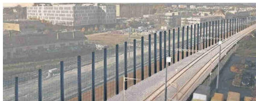
**Le saut-de-mouton s'étendra le long de la plaine de Malley. A gauche, la paroi de chantier qui doit isoler les travaux de l'exploitation ferroviaire.** DR
