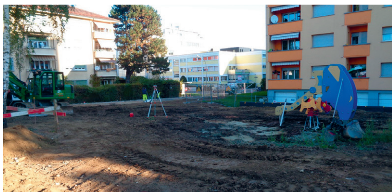
Etat des travaux de réaménagement le 21 septembre 2017.
