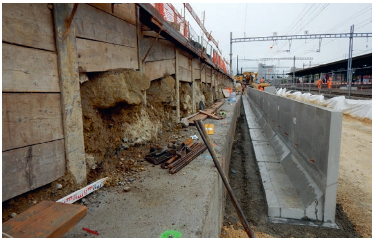
Construction du mur du futur quai 4
