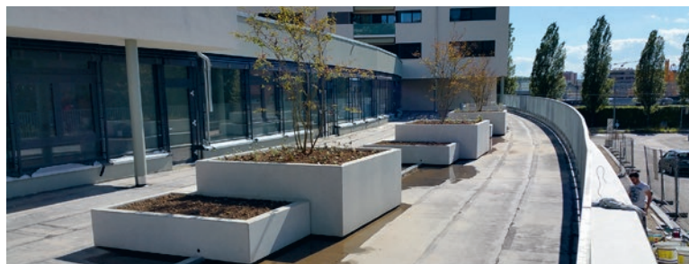
«Le Tournesol» va s'installer provisoirement dans les locaux scolaires de la Croisée, sis à l'avenue du 24-Janvier 1D
