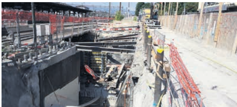
Escalier nord en chantier
