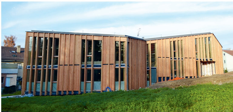
Un des chantiers mené à bien cette année par la Ville: le nouveau bâtiment de la garderie Le Tournesol, qui ouvrira ses portes cet été.
