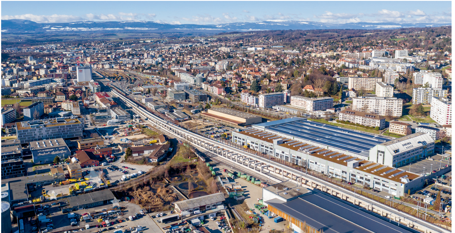
Vu pour vous: la construction du saut-de-mouton avance. La 1 re étape de réalisation est terminée; à partir du 20 avril, une partie du trafic ferroviaire basculera au sud de l'ouvrage pour permettre de poursuivre sa construction au nord et à l'est.
