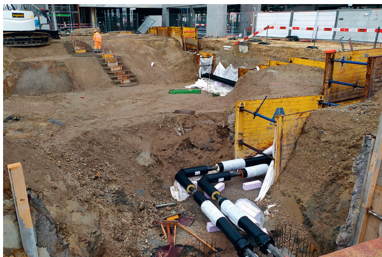
Sur la place de la Gare sud, les travaux de réseaux ont démarré au début de cette année avec les fouilles pour les conduites de chauffage à distance (CADouest) qui alimenteront le futur bâtiment CFF sur Epenex et le bâtiment voyageurs.
