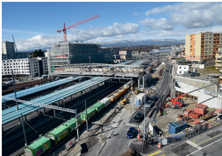
Etat d'avancement des travaux sur la place de la Gare nord, mars 2020.
