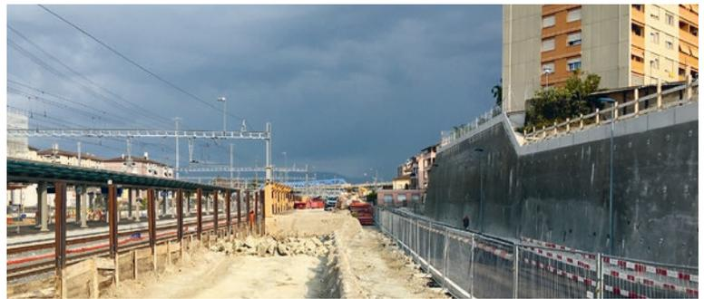
Les travaux de la passerelle Rayon Vert ont repris début août avec la construction de l'appui de la passerelle sur le futur quai 4.
