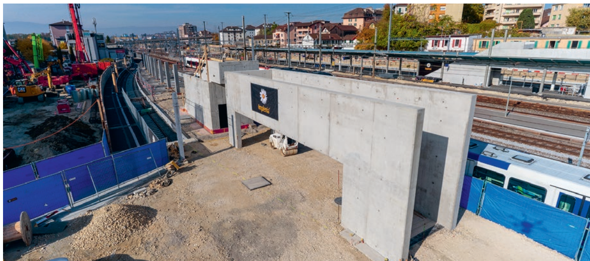
Parmi les nombreux investissements en cours: la Passerelle Rayon Vert. Ici, l'appui sur le futur quai du m1 © Implenla
