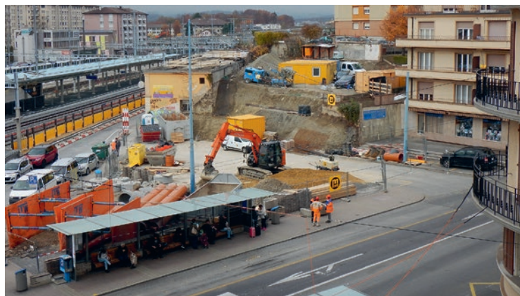
Même endroit en novembre 2018, après le défrichage et la démolition du terminus et de la villa
