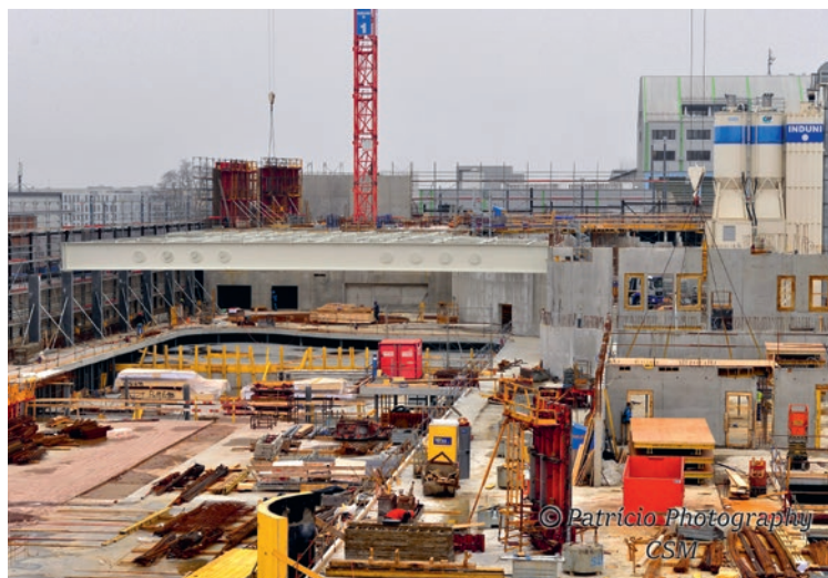
Les poutres au-dessus de la piscine sont posées
