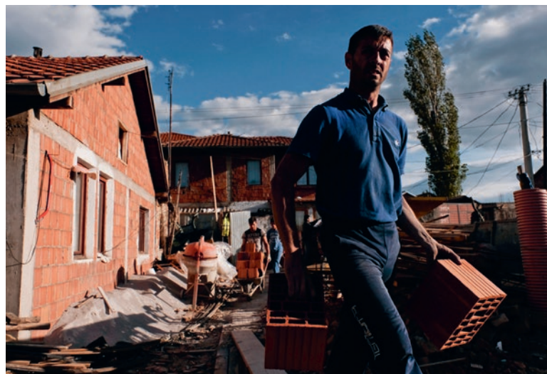
Les habitants des villages procèdent eux-mêmes à la rénovation de leurs maisons © FEDEVACO
