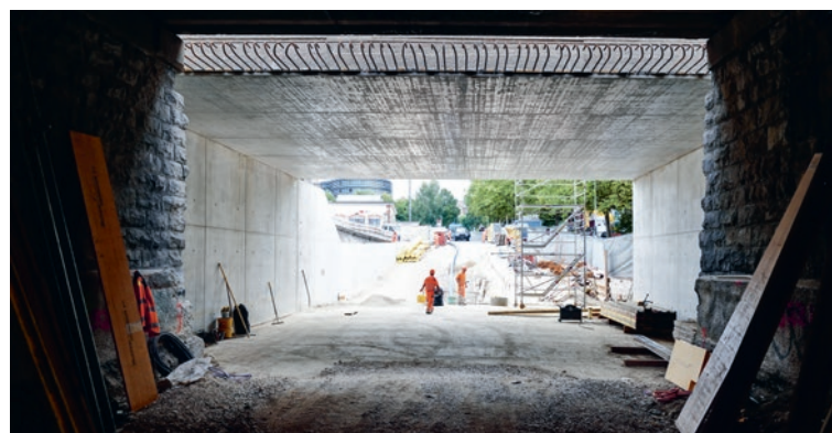
Passage inférieur du Léman - vue depuis le sud
