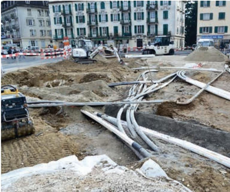
Extension et adaptation des réseaux de distribution multi-fluides sous la chaussée
