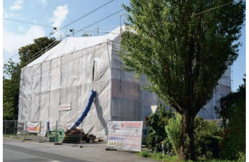
La Ferme des Tilleuls recouverte d'un filet de protection et d'une couverture pour permettre l'exécution des travaux par tous les temps
