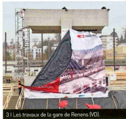
3 | Les travaux de la gare de Renens (VD).
