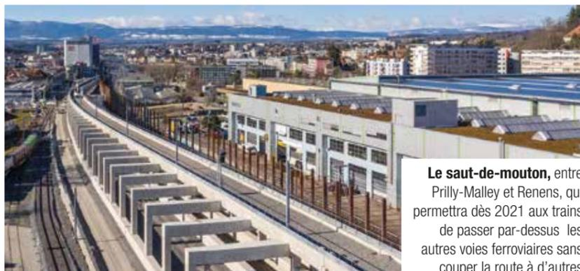
**Le saut-de-mouton**, entre Prilly-Malley et Renens, qui permettra dès 2021 aux trains de passer par-dessus les autres voies ferroviaires sans couper la route à d'autres
