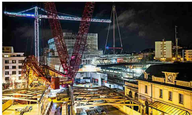
Une grue de 94 m a posé les éléments de la passerelle. -KEY L'interview du chef de projet est à découvrir sur notre app.
