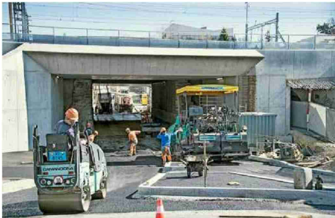
Le chantier est lié à l'ajout d'une 4e voie ferroviaire. PATRICK MARTIN
