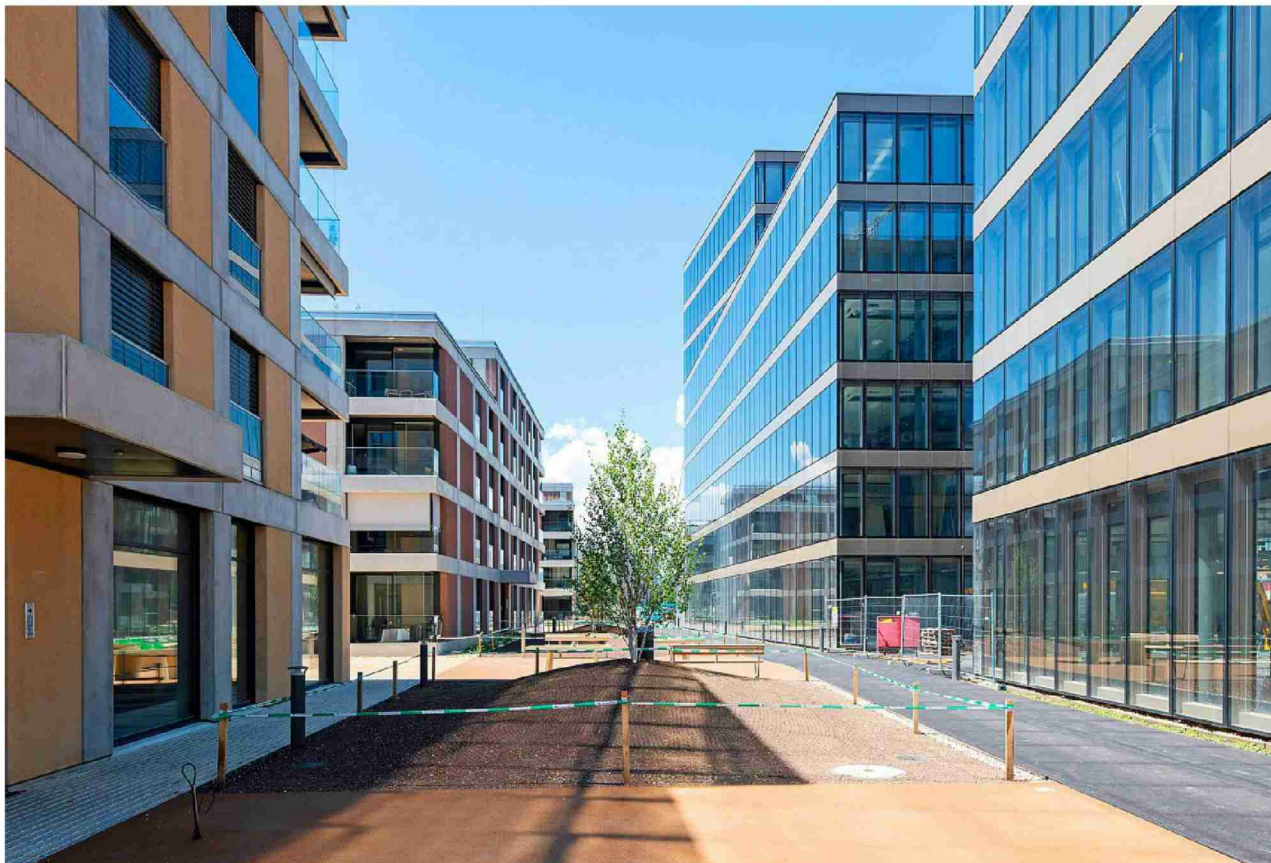
Au fil de l'été, 800 employés s'installeront à Renens. À terme, ils seront 1000 à travailler au nouveau siège.
