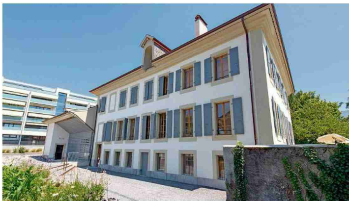
La Municipalité a mandaté une expertise externe des dépenses relatives au chantier de la Ferme des Tilleuls. F. CELLA
