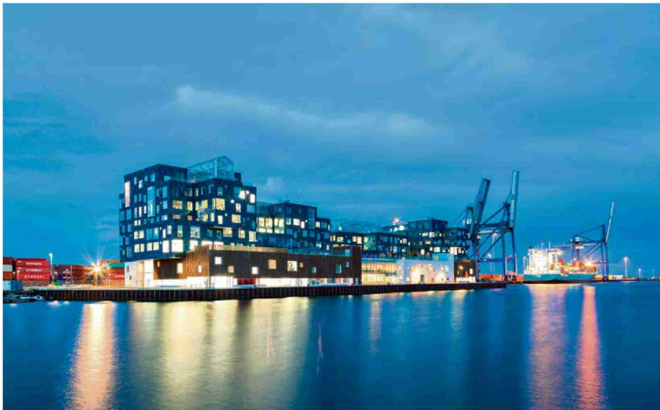
La façade du bâtiment de l'International School de Copenhague est une mosaïque bleu turquoise composée avec le verre solaire Kromatix. (OLIVER FORSTNER/ALAMY STOCK PHOTO)
