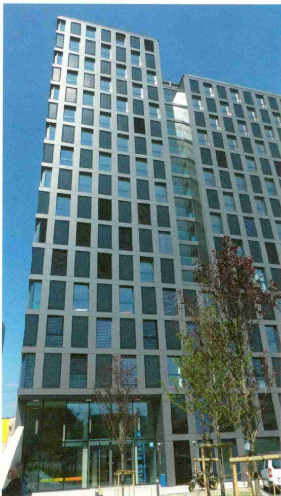
La façade est réalisée en tôle d'aluminium de couleur gris-bleu foncée; une réinterprétation contemporaine de la teinte originelle du silo existant.
