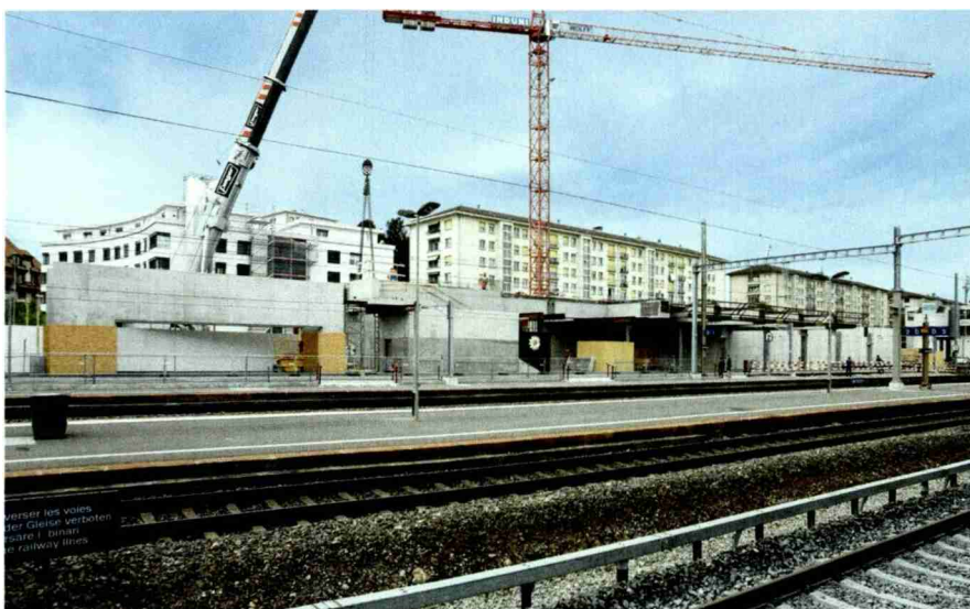
En bordure du quai 1, une pile de la passerelle Rayon Vert est en cours de construction.
