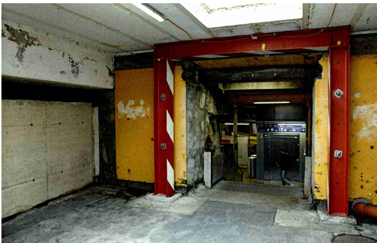
Dans le passage inférieur, des percements latéraux sont effectués pour intégrer des escaliers et des rampes d'accès aux quais.
