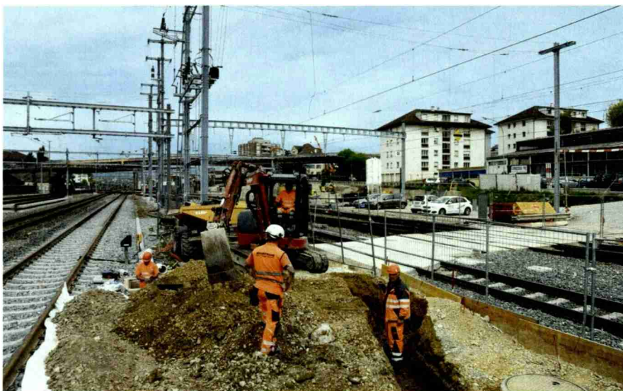
Au bout du quai 2, les ouvriers prolongent un passage provisoire pour que les camions puissent reculer sur la voie, pour la construction de la marquise.
