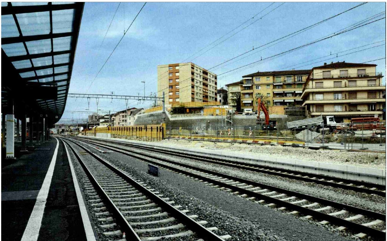
Sous le groupe d'immeubles, on aperçoit la paroi cloutée qui borde la petite rue du Terminus.
