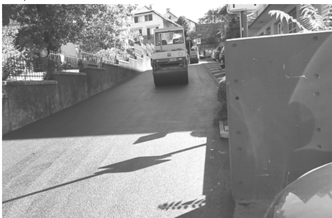
Pose du tapis sur la montée du chemin des Airelles
