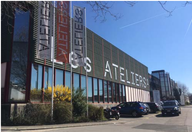
Les Ateliers au Closesel
