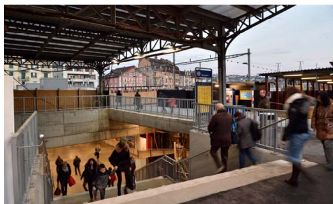
Entrée du nouveau passage inférieur voyageurs au sud
