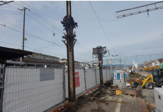
Démolition du demi quai 3 et début du chantier Rayon Vert
