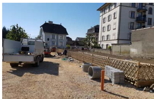
Travaux du parc de l'Avenir
