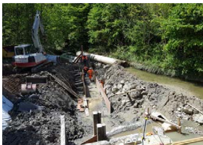
Déversoir Broye nouveau collecteur traversée Mèbre
