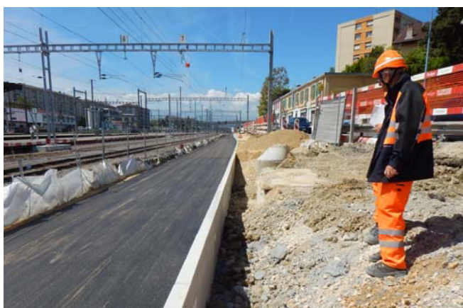
Construction plateforme voie 7 et bordures du futur quai 4
