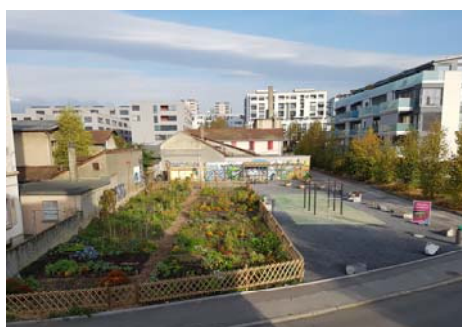
Fin des travaux
