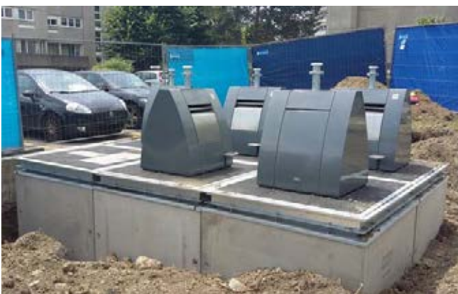
Mise en place de conteneurs enterrés
