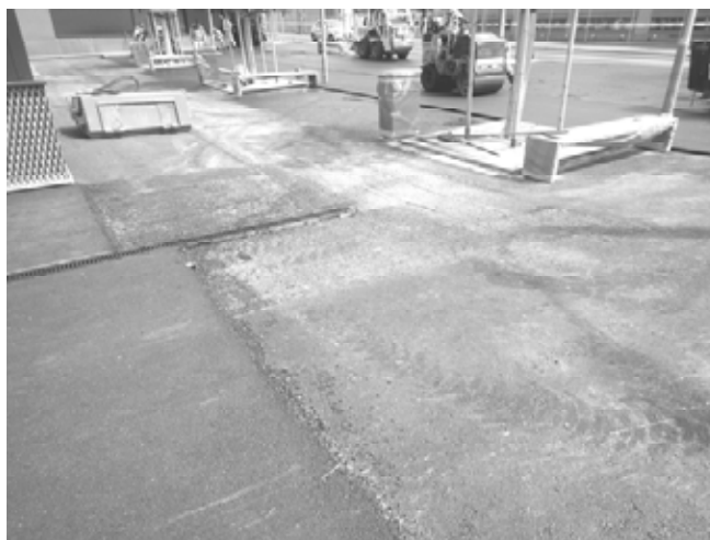
Pose du tapis autour du Gymnase de Renens
