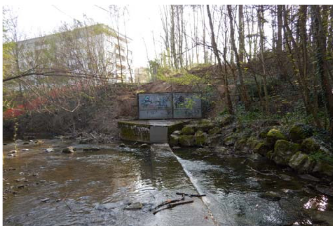
Déversoir avant travaux
