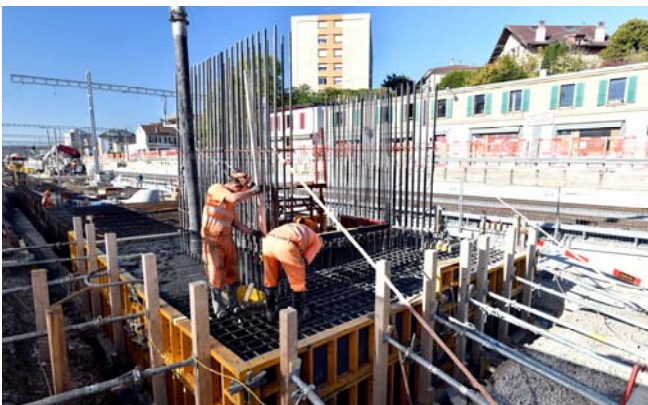
Bétonnage des fondations Rayon Vert sur quai 3
