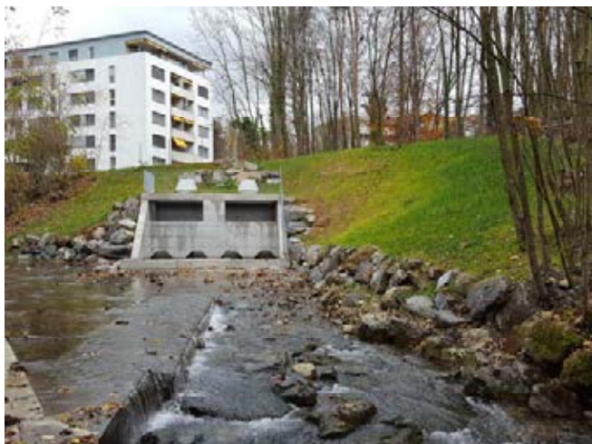
Déversoir après travaux
