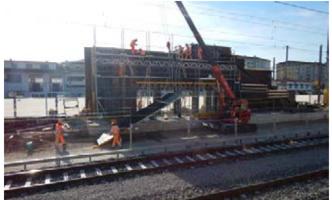
Coffrage murs voiles Rayon Vert - Chantier entre les voies en service, espace restreint
