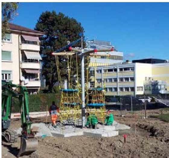
Pendant les travaux
