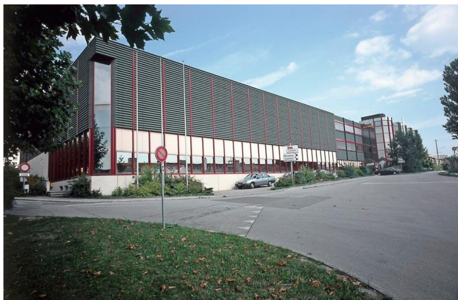
Site du Closel, ancien bâtiment des IRL - 2015
