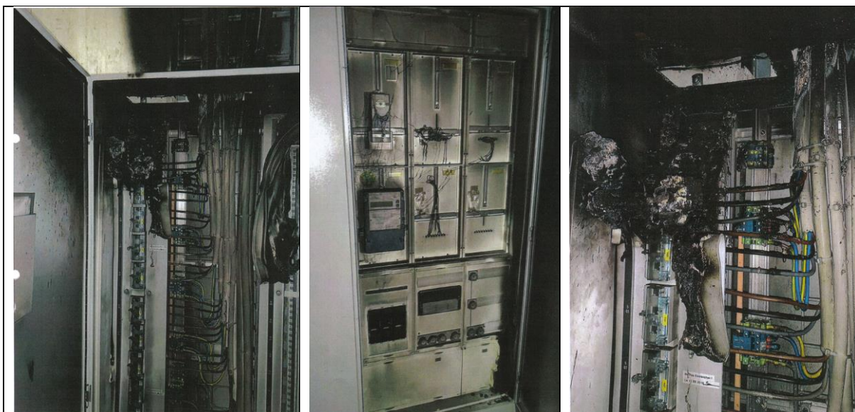
Les images montrent l'ampleur des dégâts sur le tableau. Les disjoncteurs paraissent intacts, mais l'introduction semble être le point de départ du feu.
