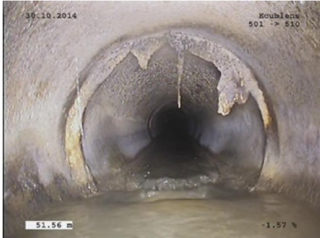
Calcaire aux joints et dépôts sur le radier
