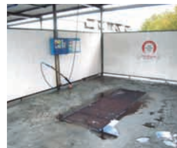
Une place de lavage conforme
