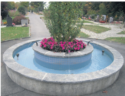
Un système ecofontaine a été installé sur la fontaine à l'entrée du cimetière de Renens
