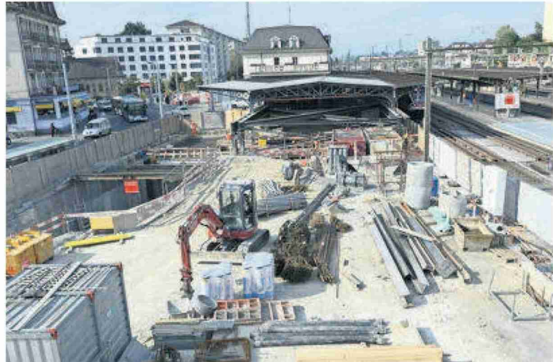
Les travaux sont très présents en gare de Renens. Un bâtiment s'élèvera sur l'espace en chantier au premier plan.
