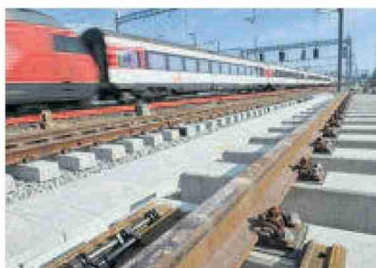
La 4e voie est déjà posée sur certains tronçons entre Renens et Lausanne.
