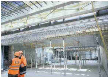
Gare de Renens: des ponts provisoires permettent le passage des trains durant l'aménagement du nouveau passage souterrain.
