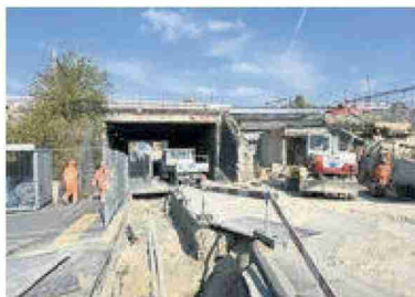
Proche de la gare de Renens, un passage routier sous les voies doit être reconstruit.
