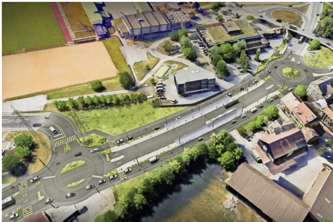
L'arrêt Bré, à Crissier, est conçu comme un hub pour les bus rapides de la ligne BHNS. URBAPLAN
