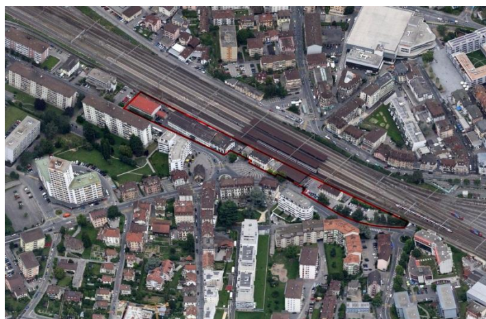
vue aérienne du périmètre
