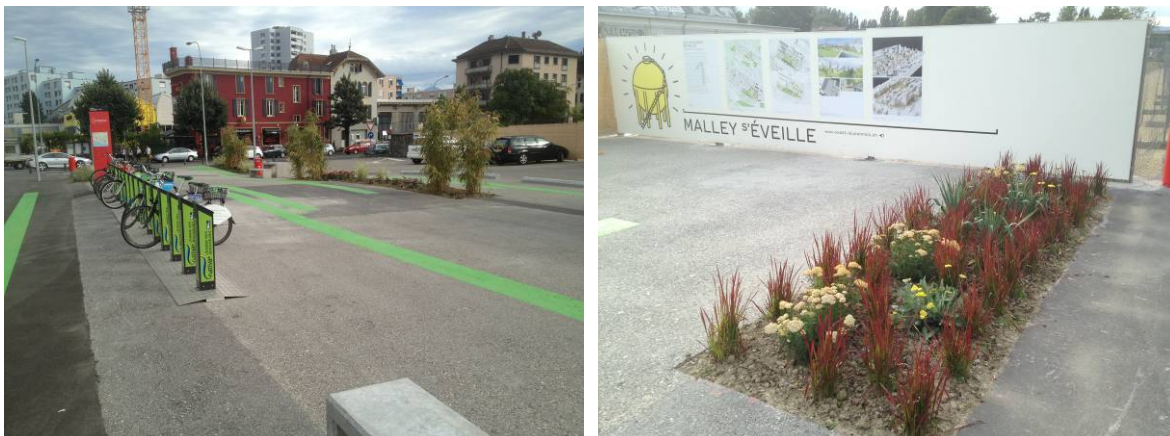
Vues de l'aménagement provisoire au droit de la halte Prilly-Malley
